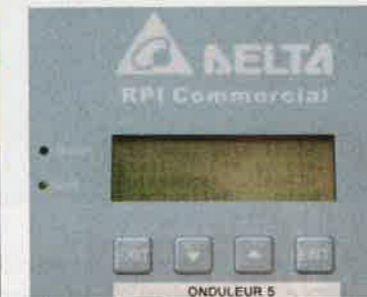
Contrôle. Un écran permet de vérifier visuellement la production des panneaux photovoltaïques.
