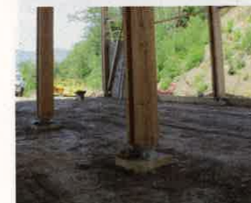
Fondations. Elles bénéficient de la technique dite de la « semelle isolée ». Le béton a fait l'objet d'une analyse en laboratoire.
