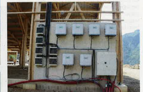
Onduleurs. Ils convertissent et acheminent l'électricité. Guillaume a augmenté leur puissance pour leur assurer une plus grande longévité. Chaque bâti a une puissance de 190 kWc.
