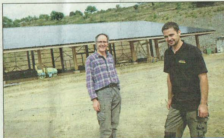
Jean Quilleret et Guillaume Husson devant les panneaux solaires en capacité de produire 500 MWh par an.
